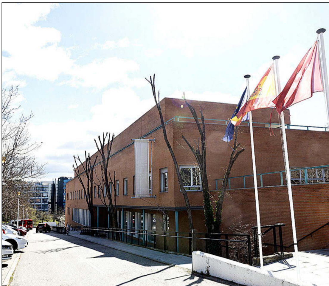
Fachada de la residencia de ancianos Moscatelares en el municipio de San Sebastián de los Reyes. JAVI MARTÍNEZ
