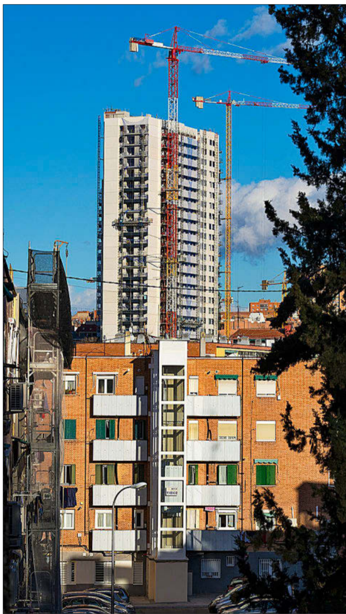
Edificio en construcción en Valdezarza, Madrid. ÁNGEL NAVARRETE
